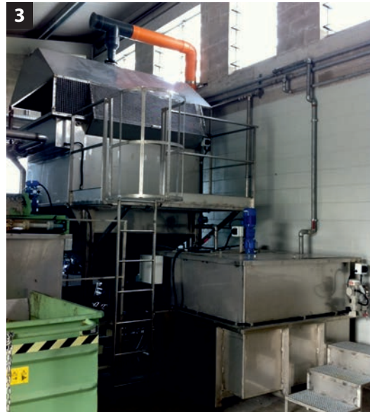
Fig. 3 Unità di decantazione e vasca di lavaggio
