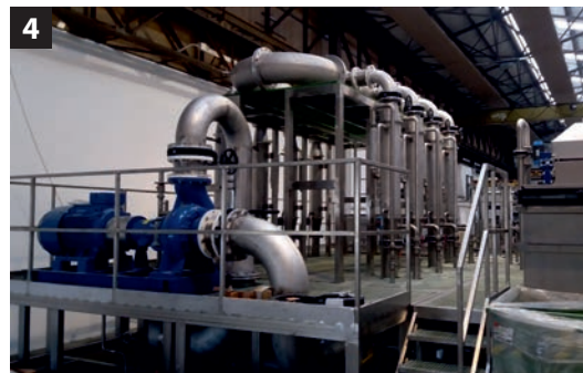
Fig. 4 Sezione ultrafiltrazione
