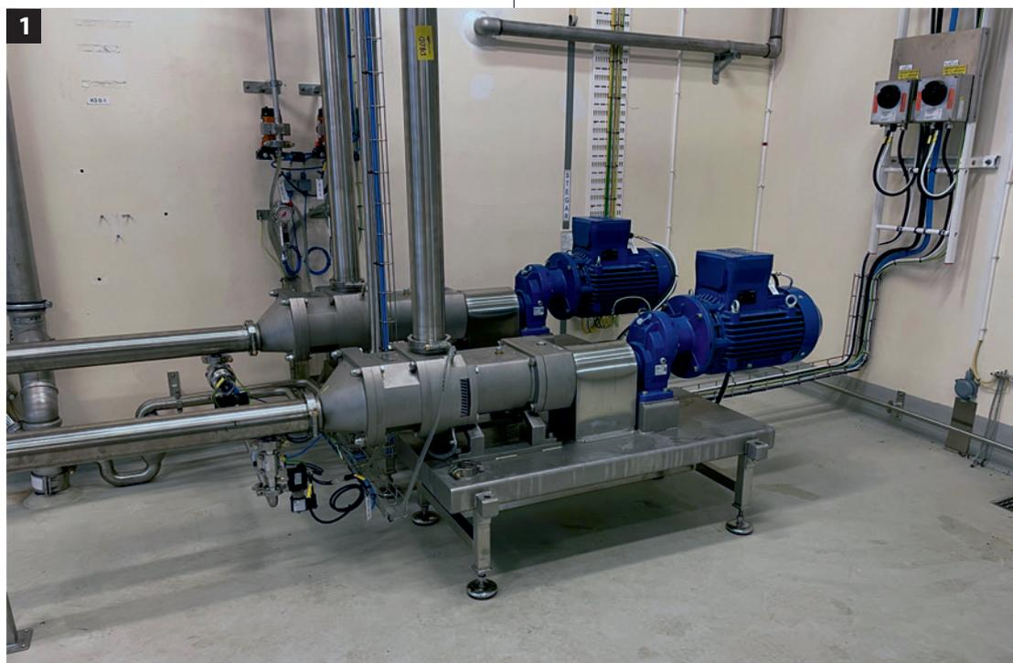
rigorosa applicazione dei principi di hygienic design e le certificazioni a livello internazionale rilasciate dagli enti preposti, sono aspetti determinanti per consentire il regolare funzionamento delle pompe impiegate in questi settori, massimizzarne le prestazioni, mantenere bassi i consumi energetici nelle fasi di sanificazione e impedire la contaminazione dei prodotti pompati.
