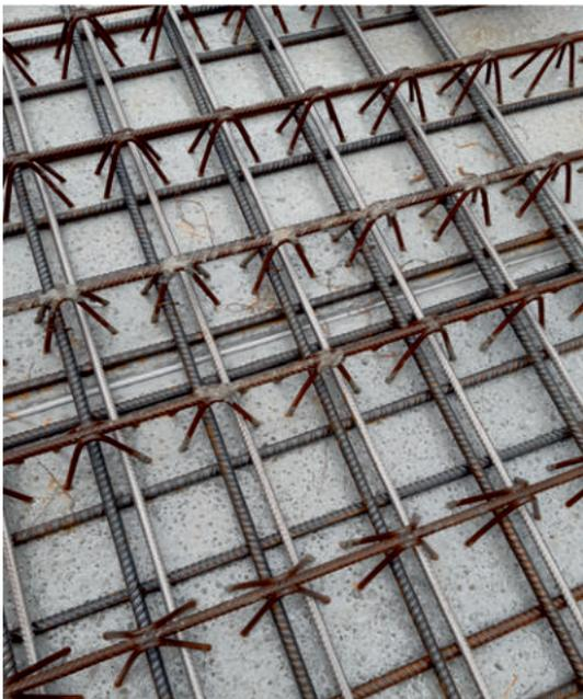
corrosione da ambiente esterno. L'impiego combinato di acciaio al carbonio ed acciaio inossidabile, chiaramente visibile nelle immagini riportate, non comporta un aumento della velocità di corrosione dell'acciaio comune rispetto a quanto si verificherebbe in presenza di sole barre di
