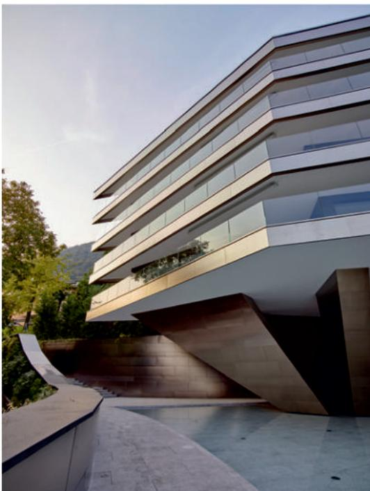
In perfetta armonia con le pareti vetrate, il rivestimento esterno dell'edificio è realizzato con lamiere di acciaio inox colore Champagne Pallinato; si tratta di prodotto piano in EN 1.4301 (AISI 304) avente per spessori 1 / 1,2 mm. Le lamiere sono state assemblate e sostenute da una sottostruttura in alluminio. In totale sono state impiegate circa 40 tonnellate di acciaio inox.
