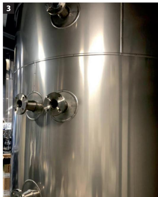
Il secondo sistema di coibentazione qui presentato riguarda un reattore per resine (**Fig. 2 e 3**). La coibentazione è stata eseguita utilizzando materiale isolante a celle chiuse altamente flessibile in elastomero espanso estruso, composto da diversi strati di materiale polimerico, capaci di operare in un range di temperatura tra i -50 ed i 150 °C. Il tutto è completato da un rivestimento metallico esterno in acciaio inossidabile EN 1.4301 di spessore 0,6 mm, con finitura 2B.
