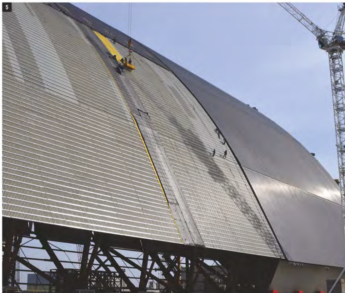
Fig. 5 • Fase di installazione della copertura esterna dove sono stati impiegati pannelli in acciaio inossidabile EN 1.4404 (AISI 316L), con finitura 2B.
