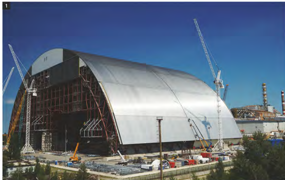
Fig. 1 • Una visione d'insieme del nuovo "sarcofago". NSC (New Safe Confinement) può resistere a temperature da -45 °C a 45 °C, a tornado di livello 3, con venti che superano i 250 Km/h, ed a un terremoto di intensità 6 della scala MSK64.
