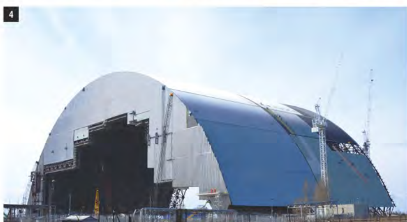
Fig. 3 • Fase di installazione della parete interna in acciaio inossidabile EN 1.4301 (AISI 304) con finitura 2R (0,5 mm di spessore x 439 mm di larghezza). La finitura altamente riflettente permette di "illuminare" l'interno del "sarcofago".
