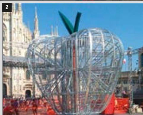
**Fig. 2** – Una foto che ritrae le fasi di montaggio della Mela in Piazza Duomo. Per la struttura metallica, è stato utilizzato il sistema di assemblaggio a secco, che prevede l'uso di giunzioni di tipo meccanico, come viti e bulloni, al posto di collanti e sigillanti.
