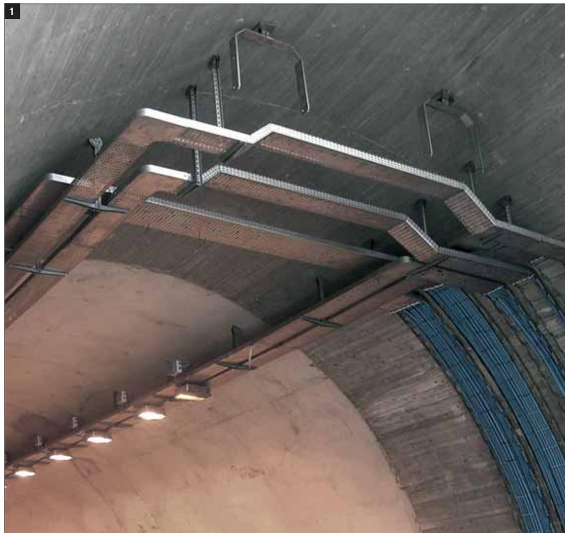
Fig. 1 – Sistemi portacavi realizzati in acciaio inossidabile EN 1.4404 (AISI 316 L) all'interno delle gallerie del tratto autostradale Messina-Palermo, dove la vicinanza all'ambiente marino richiede una maggiore resistenza alla corrosione.
