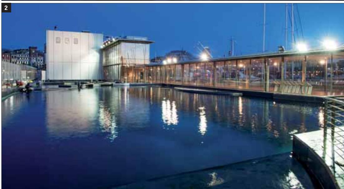
**Figg. 1, 2** – Il nuovo Padiglione, con una lunghezza di 94 m, 28 di larghezza e 23 di altezza, è stato costruito in galleggiamento nel bacino di carenaggio nel porto di La Spezia e trasportato al cantiere di Genova Voltri per i lavori di completamento. Solo in un secondo tempo, quando l'opera era ormai quasi completa, è giunto nel Porto Antico di Genova, dove è stato zavorrato. In seguito, è stata effettuata la realizzazione dei collegamenti con l'Acquario esistente e con la Nave Blu.
