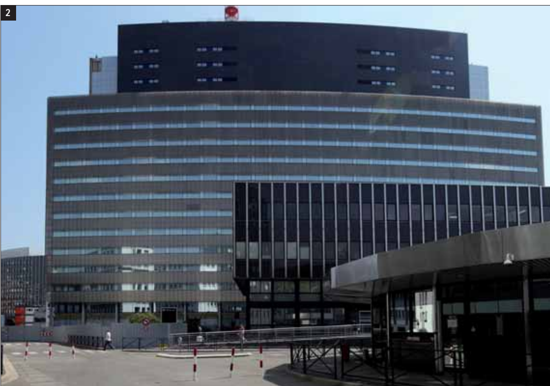
Figg. 1, 2 – L'edificio "Tour F" presenta facciate continue realizzate con sistema a cellule strutturali e tamponamenti vetriati e metallici. Una parte delle facciate sostiene una seconda pelle realizzata con lamiere forate satiniate in acciaio inox EN 1.4404 (AISI 316 L).
