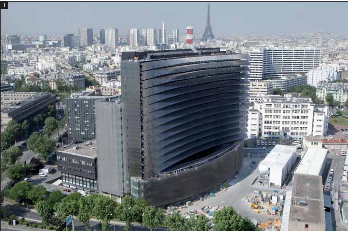
Figg. 1, 2 – L'edificio "Tour F" presenta facciate continue realizzate con sistema a cellule strutturali e tamponamenti vetriati e metallici. Una parte delle facciate sostiene una seconda pelle realizzata con lamiere forate satiniate in acciaio inox EN 1.4404 (AISI 316 L).
