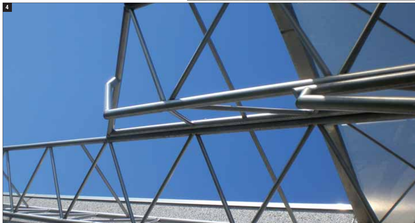
Fig. 4 – Particolare dei tubi. Le tecniche di saldatura impiegate sono state tra le più varie: TIG, MIG e ad elettrodo.
