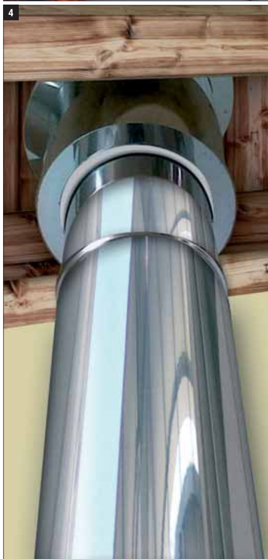
Fig. 1 e 2 – La parete esterna del modulo di attraversamento tetto è realizzata in AISI 304 e presenta un diametro di 270 mm e uno spessore di 0,4 mm.
