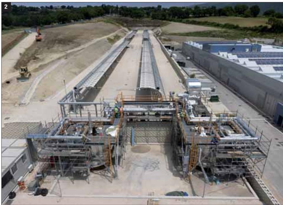
**Fig. 1** – La configurazione dell'impianto è costituita da sei collettori solari (una stringa) per circa 3600 mq. La capacità di accumulo è di: 5 ore eq – 50 t di sali.
