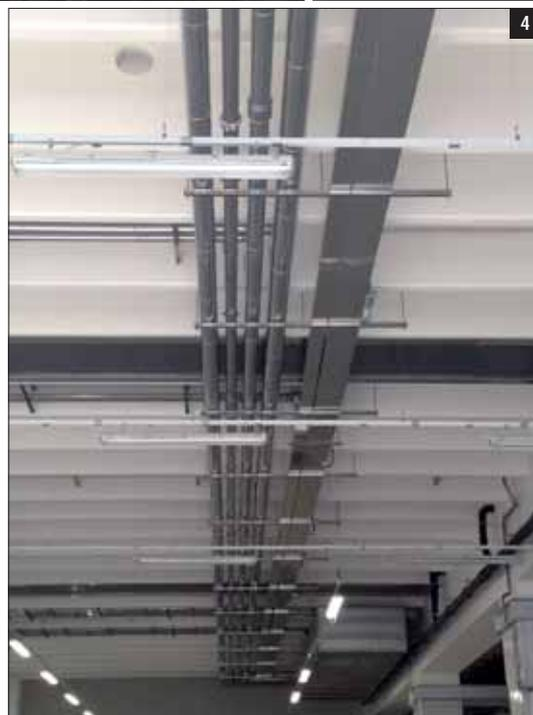
L'impiego dell'acciaio inossidabile per questi sistemi di coibentazione non solo contribuisce al mantenimento delle condizioni di temperatura desiderate ma garantisce la necessaria resistenza alla corrosione per la durabilità dell'impianto stesso. ■
