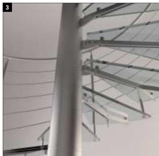
Fig. 3 – L'acciaio inox e il vetro si fondono coniugando la modernità delle linee e delle forme con la tradizione di un'accogliente scala a chiocciola. Il corrimano ha un diametro di 42,4 mm; i tondini hanno un diametro di 12 mm.
