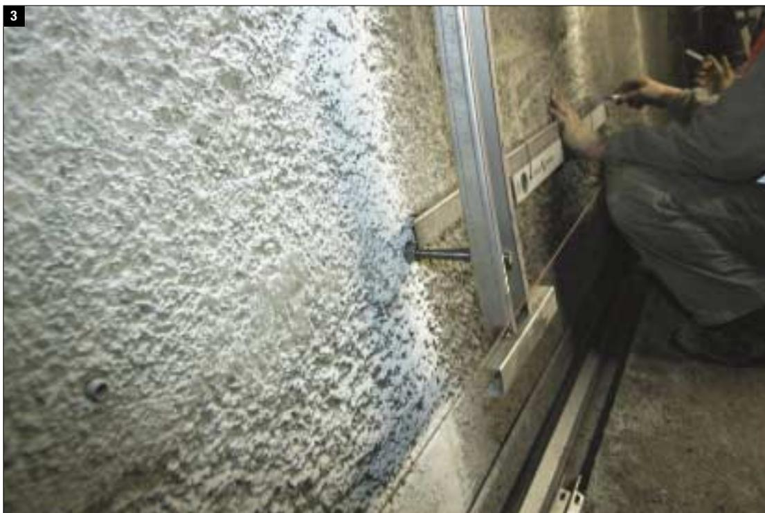
Fig. 3 – Immagine della struttura di sostegno delle pannellature laterali nel tunnel del Monte Bianco.
