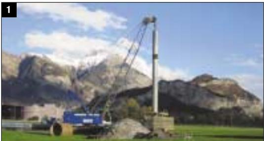
che è necessario per la formazione di una cosiddetta "colonna pozzo", quell'unità che si immerge nelle viscere della terra per estrarne uno dei nostri beni primari, ovvero l'acqua.
