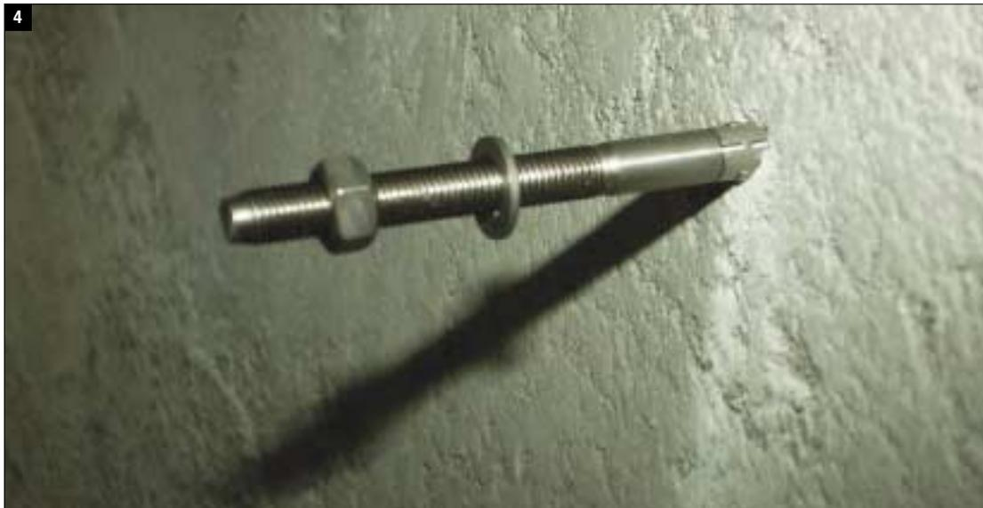
Fig. 4 – Immagine della struttura di sostegno delle pannellature laterali nel tunnel del Monte Bianco.
