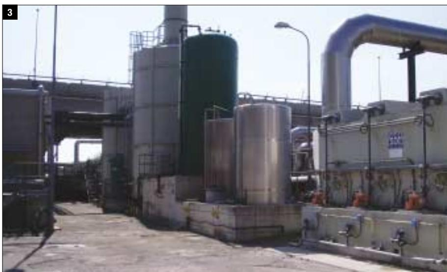
Fig. 3 - Tubazione inox di arrivo al deodorizzatore ITR, scrubber e camino.
