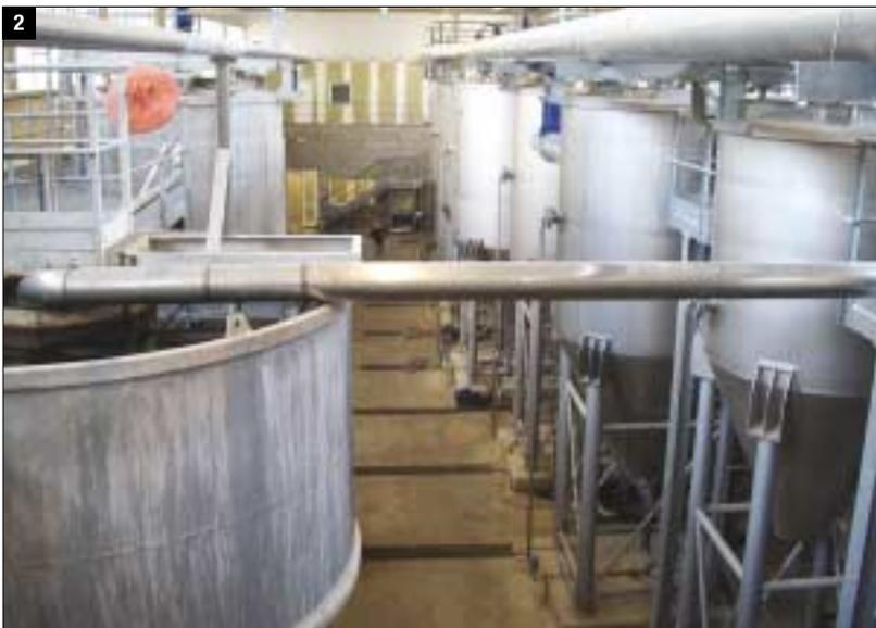
Fig. 2 - In primo piano a sinistra il decantatore, in secondo piano l'ispessitore, a destra i reattori (mixed settler).
