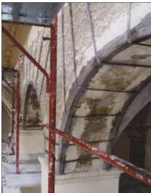
**Un particolare dell'opera di consolidamento e restauro degli archi delle colonne del Chiostro nel convento S. Agostino a Corleone (PA): applicazione del "Sistema C.A.M." con impiego di nastri di acciaio inossidabile.**
