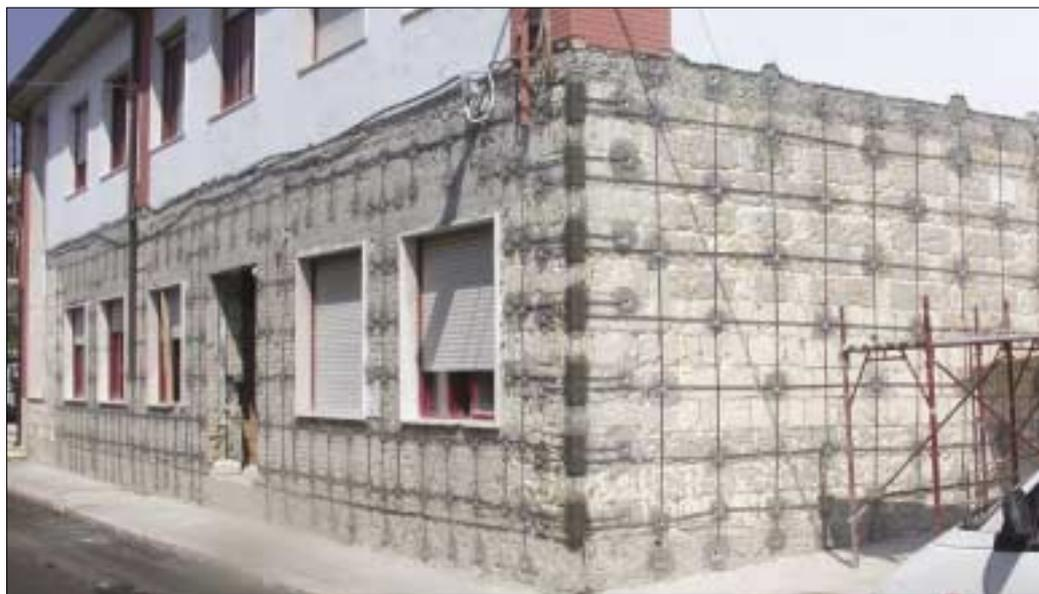
**Un particolare dell'opera di miglioramento sismico della scuola elementare del comune di Castelluccio Valmaggiore (FG): applicazione del "Sistema C.A.M." con impiego di nastri di acciaio inossidabile.**
