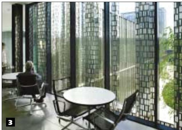
zati con lamiere in AISI 304, finitura scotch-brite, con spessore di 1,5 mm. La sottostruttura è costituita invece da correnti in alluminio e tubolari in AISI 304.
