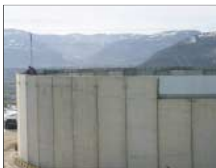
Vista della parete esterna di uno dei serbatoi a posa ultimata.
