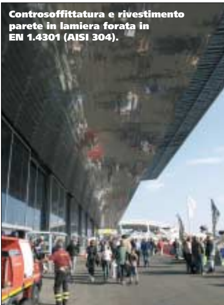
Particolare della controsoffittatura interna del padiglione B.
