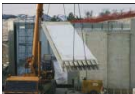
Massima cura è stata posta anche nelle delicate fasi di movimentazione dei pannelli; in particolare è da notare la presenza del film protettivo sull'acciaio inox, che ha garantito l'integrità della superficie fino a opera ultimata.
