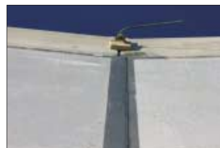
Un dettaglio di una delle saldature verticali che uniscono i diversi pannelli. Il brevetto Aquawall consente la protezione anche sul lato non in vista del cordone.
