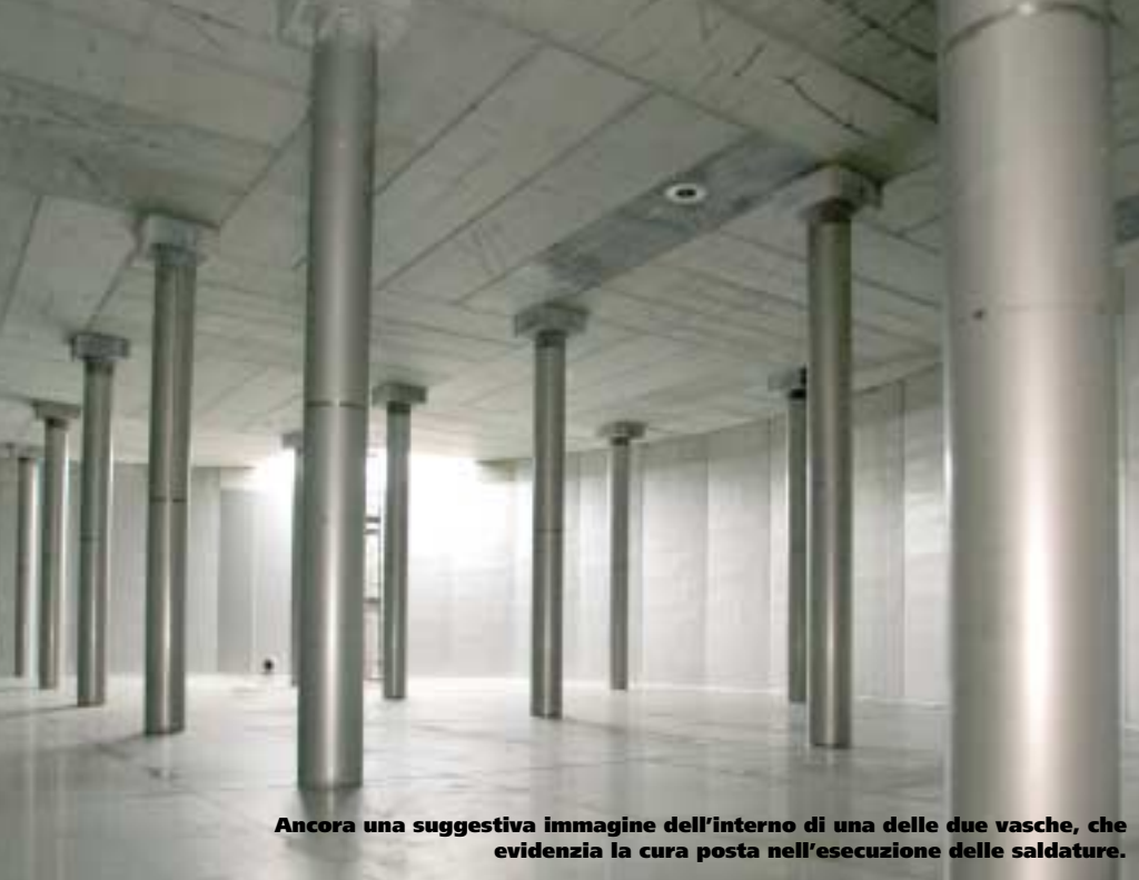
La consistente solidità del sistema Aquawall è messa in evidenza da questa immagine che evidenzia la perfetta continuità del mantello inox e la sua perfetta adesione al calcestruzzo sottostante.
