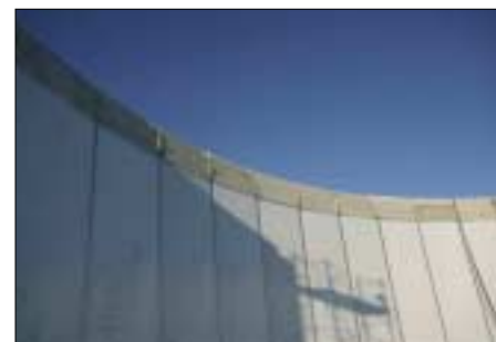
La consistente solidità del sistema Aquawall è messa in evidenza da questa immagine che evidenzia la perfetta continuità del mantello inox e la sua perfetta adesione al calcestruzzo sottostante.
