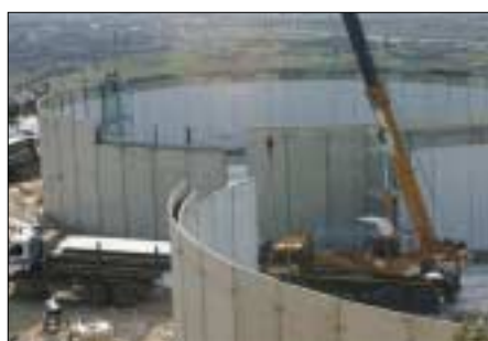
Le dimensioni delle vasche sono apprezzabili in questa immagine che mostra una fase avanzata della costruzione.
