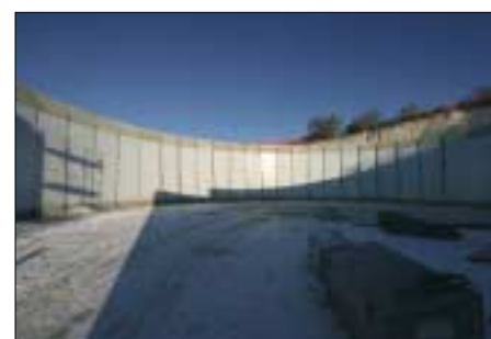
Vista dell'interno di una delle vasche prima della posa del pavimento.
