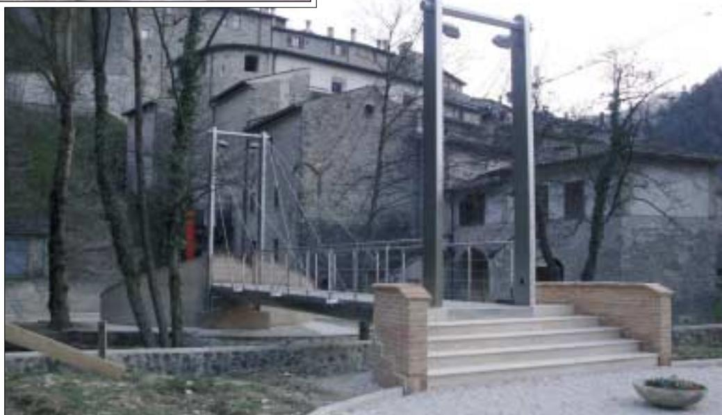
acciaio inossidabile di notevoli prestazioni strutturali e di resistenza alla corrosione, in questo modo risulta minimale a un impatto visivo, in quanto non ha né sezioni rilevanti come massa, né protezioni e trattamenti invasivi e da ripetere periodicamente per l'aspetto corrosivo: quest'ultima è una caratteristica necessaria che deve avere il ponte pedonale per l'ambiente naturale in cui è stato collocato.
