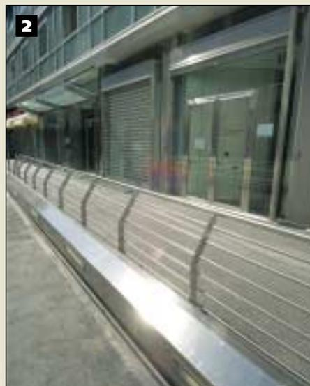
delle fioriere, sono state posate piastre di fissaggio a pavimento per mezzo di tirafondi ed è stata realizzata una struttura eseguita con "normal profilo" per il sostegno sia del carter sia del parapetto. Al carter, realizzato in lamiera inox satinata, spessore 2 mm, lavorata alla presso-piegatrice, sono stati realizzati scassi per posizionamento di lampade per l'illuminazione raso pavimento. Il parapetto (fig. 4) è stato realizzato
