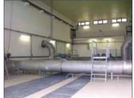
gate circa 110 tonnellate di acciaio inox EN 1.4404 (AISI 316 L). Altre 20 tonnellate circa, sempre dello stesso tipo di acciaio, sono state impiegate per la realizzazione di apparecchiature elettromeccaniche sommerse.
