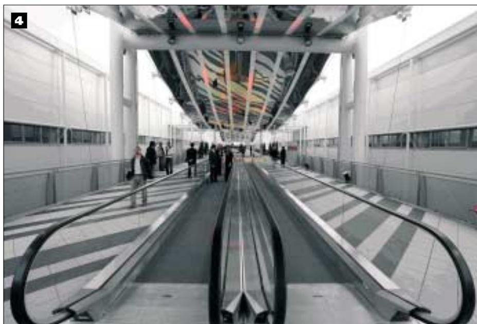
e 53,6 m di luce libera alternati: i nastri di acciaio inox (coils), sospesi per effetto del peso proprio e dei carichi permanenti, si dispongono, come detto, secondo il profilo di una catenaria naturale.
