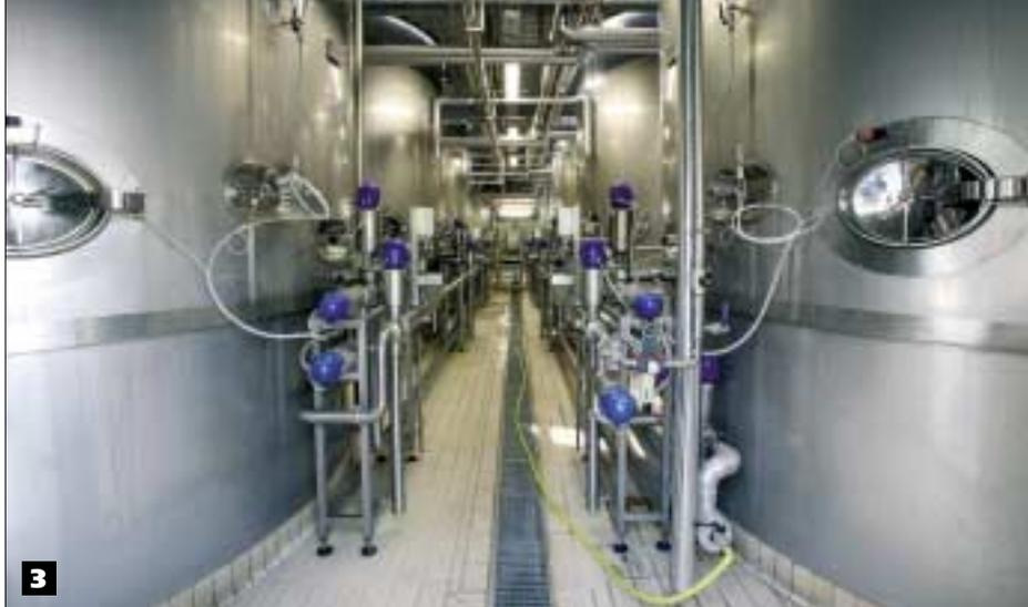
**Fig. 3 - Stoccaggio latte crudo: la base dei serbatoi con le relative linee di movimentazione del latte.**
