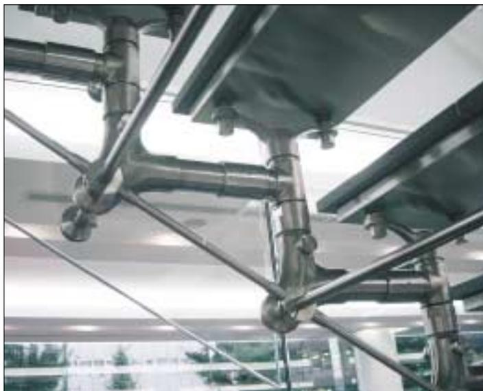
**Il modello "Regale" è stato invece scelto per le scale della concessionaria BMW di Tokyo. I supporti di sostegno in acciaio inossidabile sono fissati a parete. La ringhiera è in vetro satinato, temprato e stratificato 8+8+1,52 PVB in spessore, fissato tramite crociere e rotule inox, con corrimano in tubolare inox, diametro 40 mm. Sempre in acciaio inox, sono i piedestalli di sostegno dei pianerottoli.**
