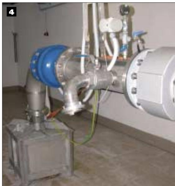
(fig. 3). La testa di pozzo (fig. 4) è stata eseguita in maniera che si apra in due metà, consentendo lo sfilamento della tubazione di mandata della pompa (38 mm) per eventuali manutenzioni, attraverso torrette areate smontabili (fig. 5).
