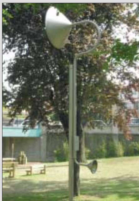
L'"Orecchio in quota" coglie e amplifica i rumori circostanti (il vento, il canto degli uccelli, il fruscio delle foglie) ed è sorretto da una struttura portante in tubolari da 102 mm di diametro. L'elemento di ascolto termina agli estremi con due elementi conici rispettivamente di diametro 250 mm sotto e 900 mm sopra (Comune di Alessandria).
