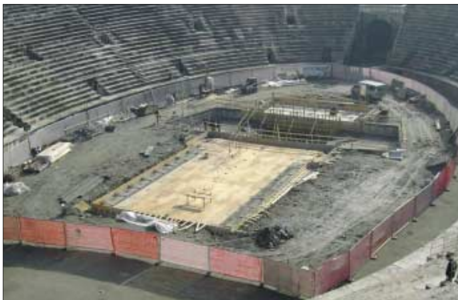
La fossa centrale durante i lavori di restauro.
