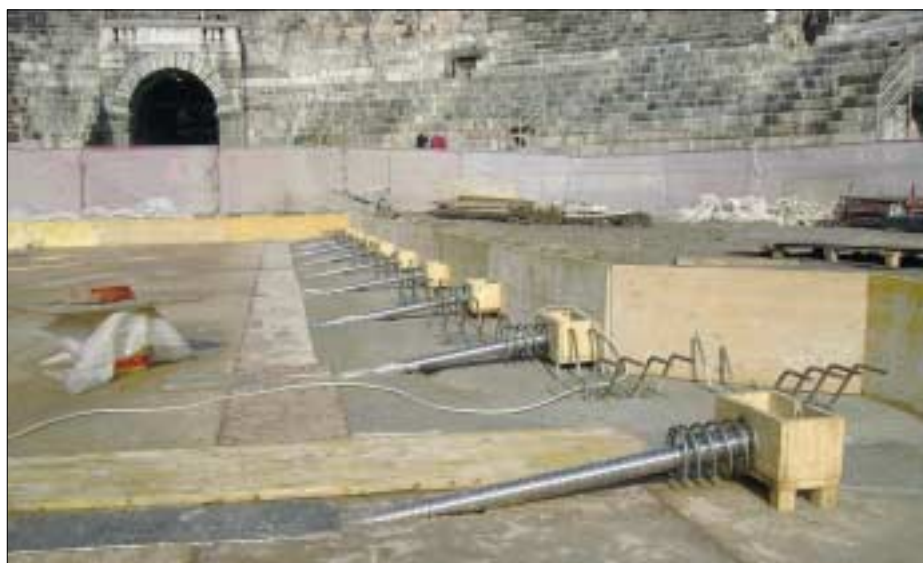
Tiranti GEODINOX QT 850 nella parte superiore.
