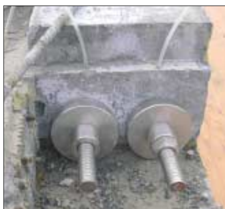
Particolare della testata di ancoraggio.
