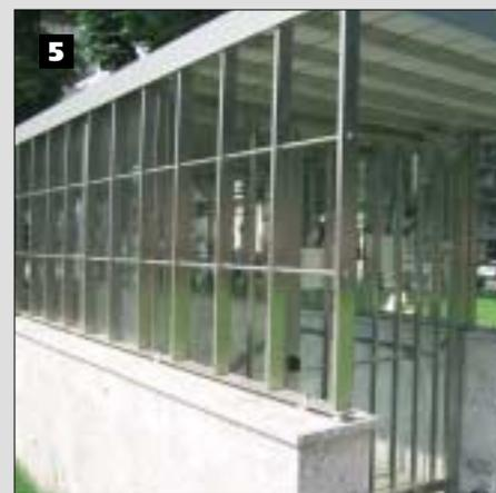
nuti da una struttura portante formata da tubolare rettangolare inox 80x20x2 mm e da correnti trasversali in tubo tondo di diametro 17 mm, sempre in EN 1.4301 (AISI 304). Dello stesso materiale è costruito il cancello a 2 ante, con finitura satinata, completo di maniglione antipanico e vetro antisfondamento 5+5 (fig. 5).
