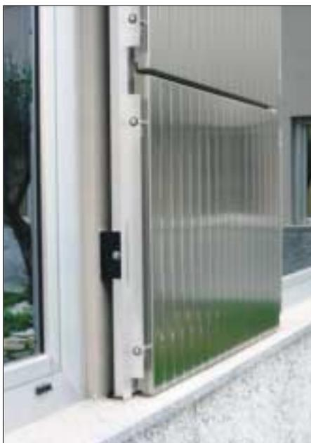
**Particolare dell'ancoraggio di un pannello alla sottostruttura.**
