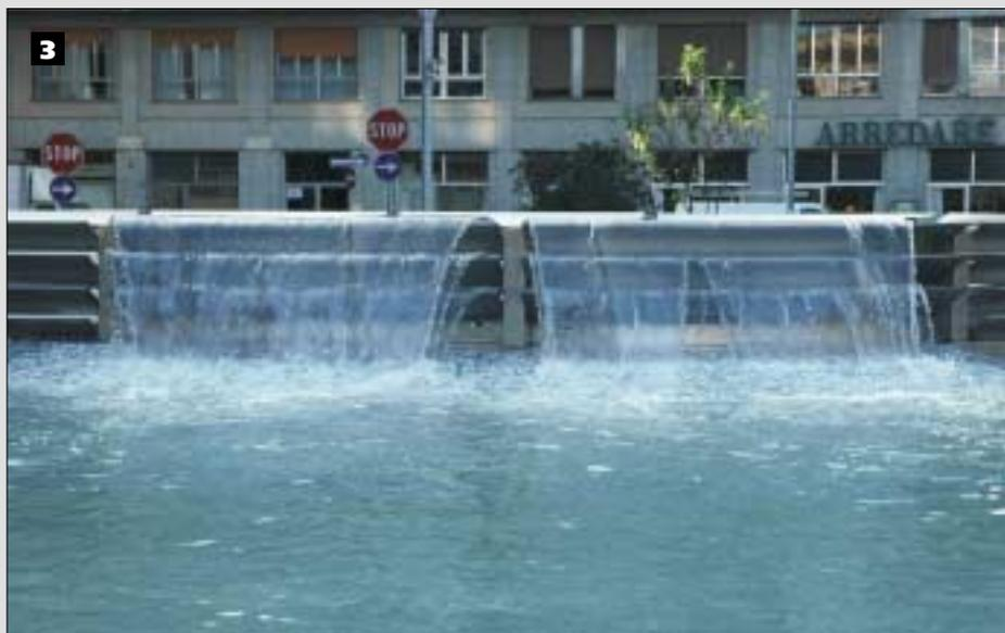
Da uno dei lati della recinzione si diparte una vasca tronco-conica, piastrellata a mosaico, terminante con un bordo circolare che, congiungendosi al muro della rampa di discesa, va a formare un semicerchio (fig. 2). Dalle lame in corrispondenza della vasca sgorga l'acqua che forma la fontana (fig. 3); queste lame sono di spessore maggiore (2,5 mm) delle altre per evitare che si deformino, in quanto la fessura di uscita è di un solo milli-
