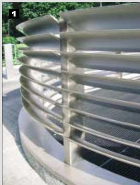
L'apertura di aerazione, di forma ovale, intorno alla quale gira la rampa di accesso delle autovetture, è chiusa con una grata ed è contornata da una particolare recinzione formata da otto anelli di lame ricavate da lamiera inox di spessore 2 mm (fig. 1). Le lame sono state realizzate da tre tronchi di cono ottenute con punzonatrice a controllo numerico e assemblate, mediante saldatura a TIG, a dodici tubolari a sezione rettangolare 200x100x4 mm.
