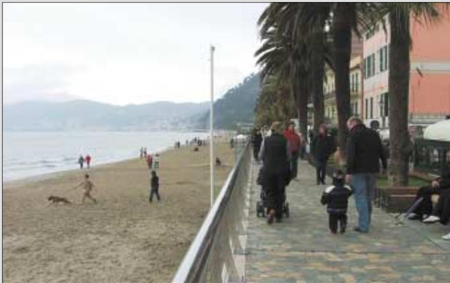
La balaustra, lunga 1.475 m, è sormontata da un corrimano tubolare lucido, con diametro 60,3 mm, fissato sulla sella dei montanti (con interasse di 1.200 mm) mediante viti inox a testa svasata.
