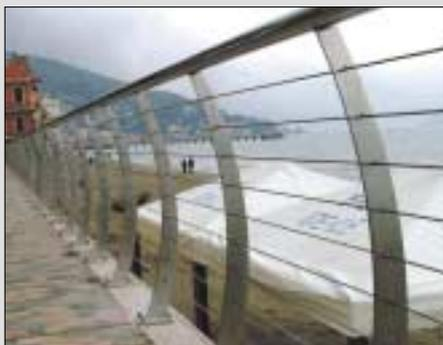
I montanti, in piatto satinato ed elettrolucidato, hanno uno spessore di 10 mm e un'altezza di 1.060 mm. La sagomatura conica misura 100 mm alla base e 50 mm all'estremità superiore. Sono stati centinati con un raggio di curvatura idoneo a impedire l'inciampo nella piastra di fissaggio a pavimento e sono dotati di 10 fori per il passaggio dei cavi. Il peso, senza la piastra, è di kg 6,8.
