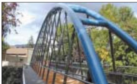
**Il ponte ciclo-pedonale sul fiume Nera che attraversa il nucleo storico di Terni. Sono in acciaio inox EN 1.4404 (AISI 316L) i piatti trasversali di base dell'impalcato, i tiranti di cortina, i plinti d'appoggio dei due tubi dell'arco (in acciaio tipo Fe 430) e i corrimano.**
