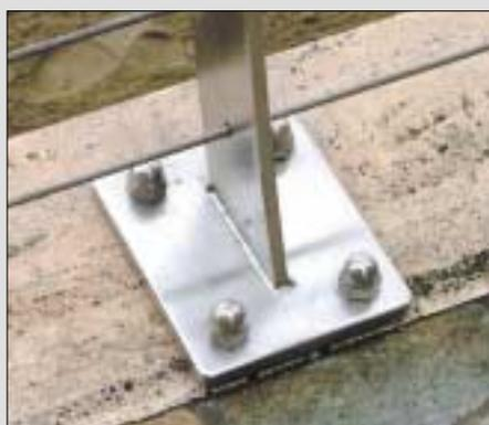
La piastra inferiore, con i bordi arrotondati, misura 180x150 mm, con uno spessore di 15 mm. Il fissaggio alla muratura è ottenuto con barre filettate in acciaio inox EN 1.4401 (AISI 316) e ancorante chimico, completate da dadi esagonali ciechi a calotta in inox del medesimo tipo. Il peso è di kg 3,40.
