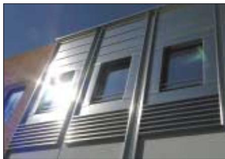
**Il nuovo centro commerciale e direzionale che sorge in una delle principali vie d'accesso a Terni. Una parte delle facciate è rivestita con pannelli inox EN 1.4301 (AISI 304).**
