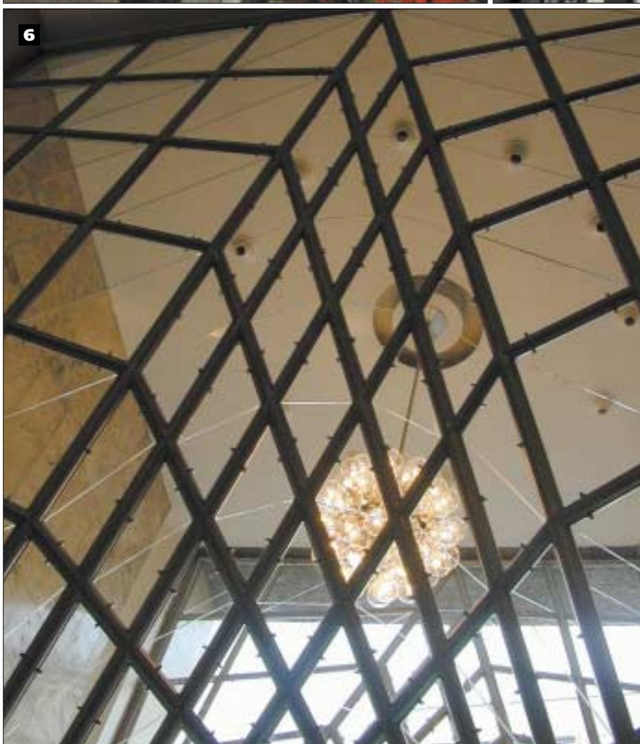
tubolari in acciaio inossidabile EN 1.4301 (AISI 304), con finitura satinata, tagliati e saldati (**fig. 2**) in modo tale da far percepire un effetto ottico di composizione di elementi curvati (**fig. 3**). I cristalli di tamponamento, con taglio ad "effetto diamante", sono stati prodotti per singoli pezzi, derivati dalle forme geometriche generate dal sistema di intreccio delle lunghe aste di acciaio (**fig. 4**).
