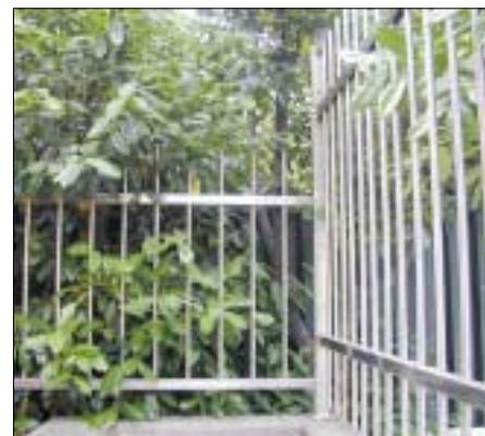
sono costituite da tubi del diametro di 20 mm, con interasse di 132 mm. L'acciaio inox utilizzato è l'EN 1.4301 (AISI 304) con finitura satinata. Il lavoro sarà completato da un cancello, anch'esso in acciaio inossidabile.
