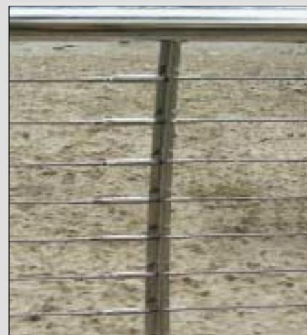
Le funi di riempimento hanno un diametro di 6 mm e sono formate da 19 fili inox EN 1.4401 (AISI 316). Ogni 25 metri, le funi sono ancorate a tenditori in acciaio inox EN 1.4401 (AISI 316) M10 del tipo pressare/pressare lucido, in corrispondenza di montanti a T (in piatto conico 90x40x1.060) controventati, per meglio sopportarne il carico.
