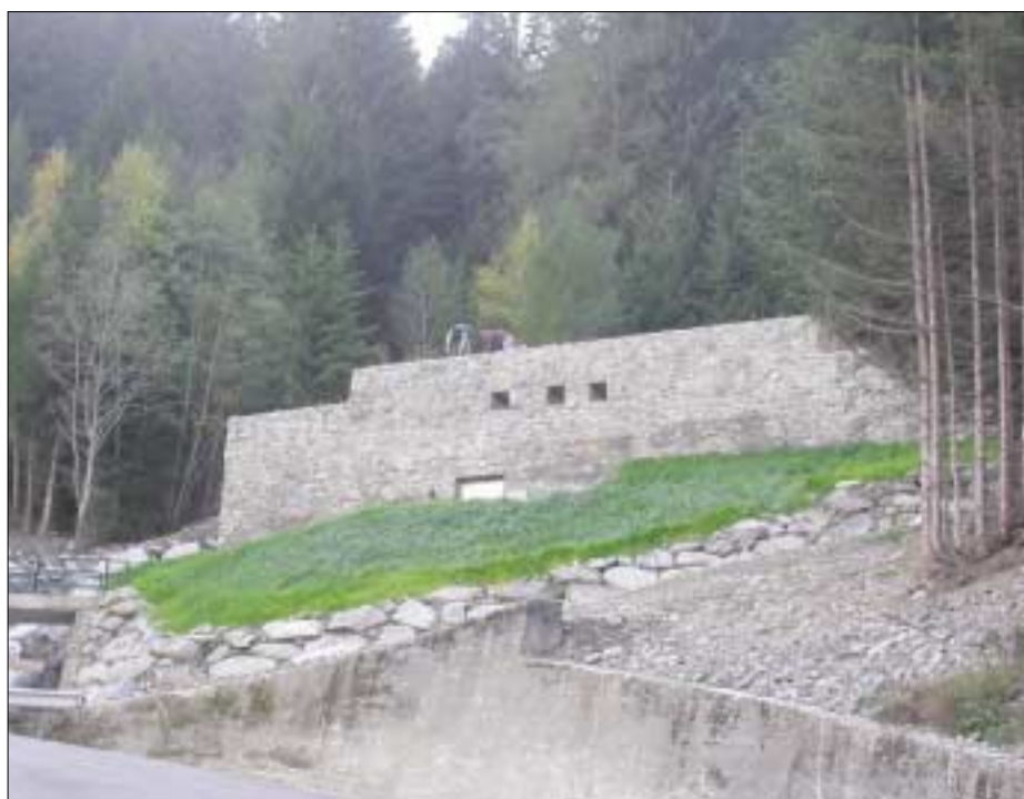
Vista esterna del complesso delle vasche di raccolta, con un rivestimento in pietra che ne attenua l'impatto visivo sull'ambiente circostante.
