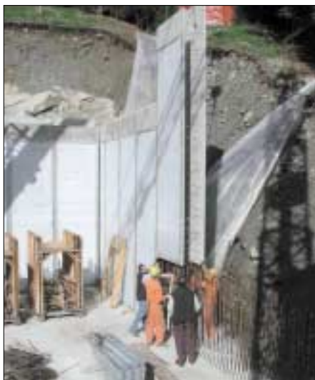
Posa dei pannelli prefabbricati composti da due lastre parallele di calcestruzzo vibrato. La faccia all'interno della vasca è ricoperta con un foglio di acciaio inox EN 1.4301 (AISI 304), spessore 1,5 mm.
