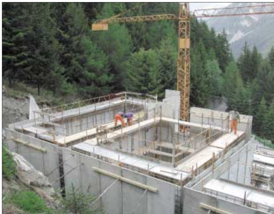
Fase di costruzione delle vasche di un acquedotto situato a quota 1.350 m s.l.m.
