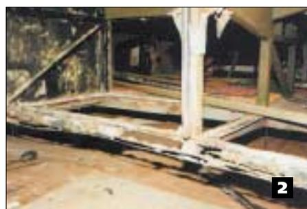
**Fig. 2 - La parte "sottocintura" di un telaio in acciaio al carbonio, completamente corrosa.**
