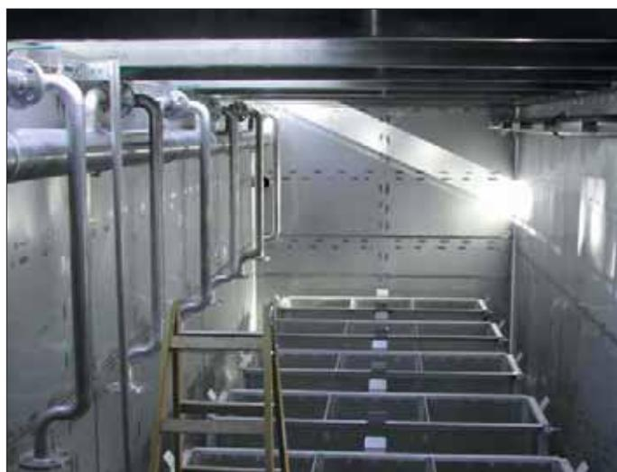
**Interno del secondo settore (aerazione a bolle medie) di uno dei container: sono visibili i cassonetti in acciaio inox di alloggiamento delle membrane.**
