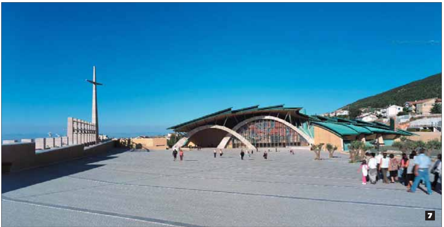
Fig. 7 - Vista generale del sagrato e della grande vetrata.
