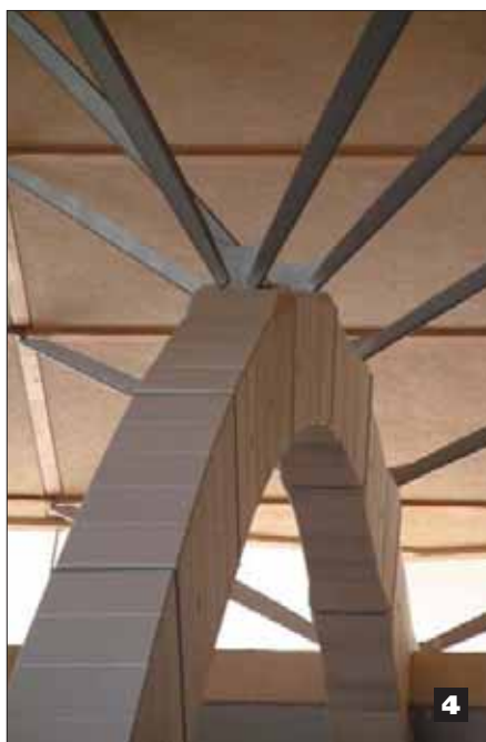
Fig. 3 e 4 - I puntoni bipodi in acciaio inox EN 1.4404 (AISI 316 L), a sezione variabile triangolare e cava, sono ottenuti per saldatura di lamiere. Ricevono i carichi della copertura e li trasmettono agli archi e quindi a terra. Fig. 5 - Elemento di fissaggio dei bipodi alle travi di copertura.
