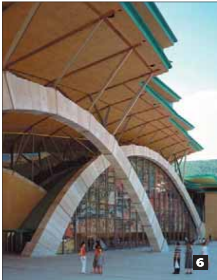
Fig. 6 - La grande vetrata deve il suo aspetto leggero e lineare all'utilizzo di travi verticali in acciaio inossidabile EN 1.4404 (AISI 316 L), che raggiungono l'altezza massima di 15 m, realizzate con profili ad H di 94x160 mm.
