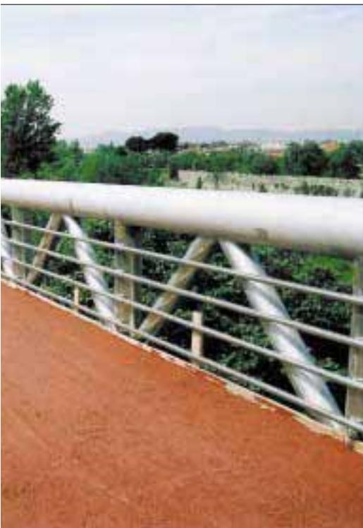
**La parte superiore dell'impalcato accoglie la sede della pista ciclopedonale, realizzata con lamiere grecate di acciaio inossidabile e soletta in cemento armato.**
