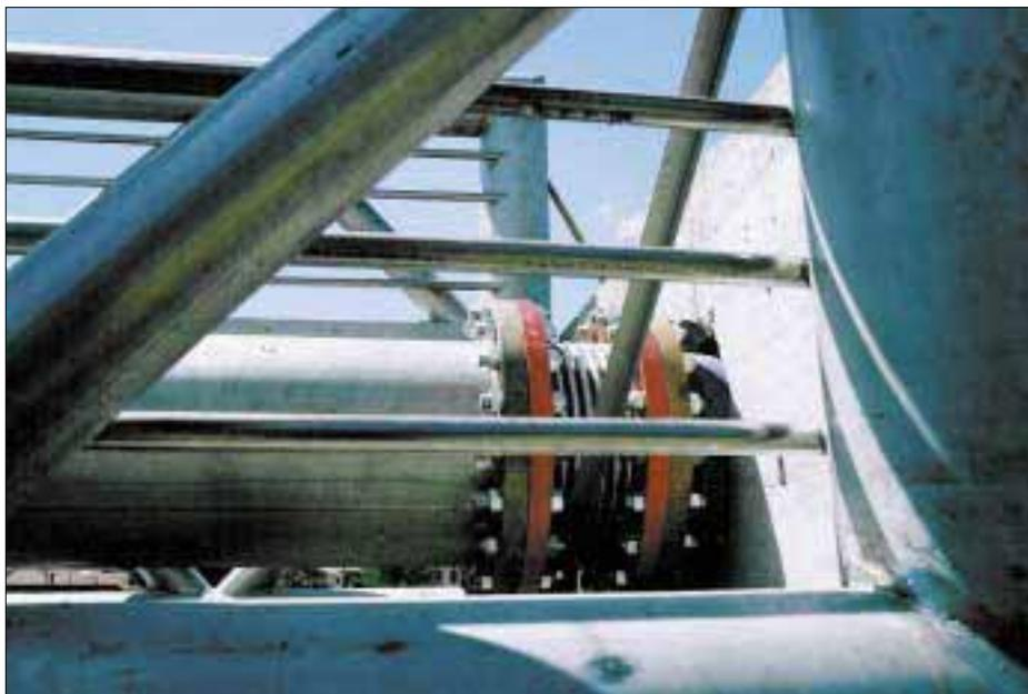
**Le tubazioni dell'acquedotto posate sulle passerelle sono in acciaio inossidabile. Appositi giunti elastici compensano le differenti dilatazioni termiche e isolano i differenti materiali impiegati per le condotte.**
