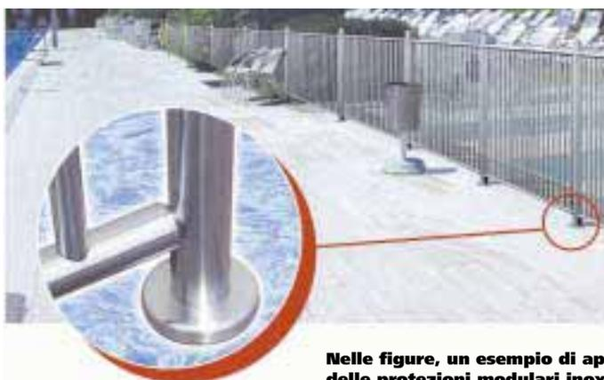
**Nelle figure, un esempio di applicazione delle protezioni modulari inox.**
