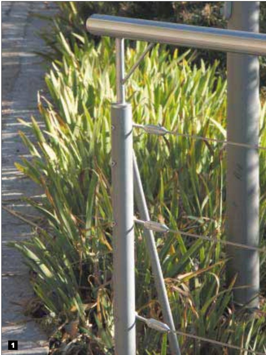
**Fig. 1 - I corrimano sono realizzati in EN 1.4301 (AISI 304).**
