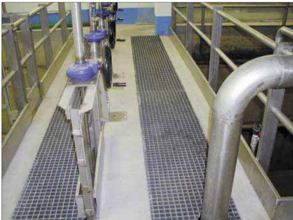
**A sinistra:** zona di camminamento delle vasche di ossidazione con paratoie e tubazioni in EN 1.4301 (AISI 304).
