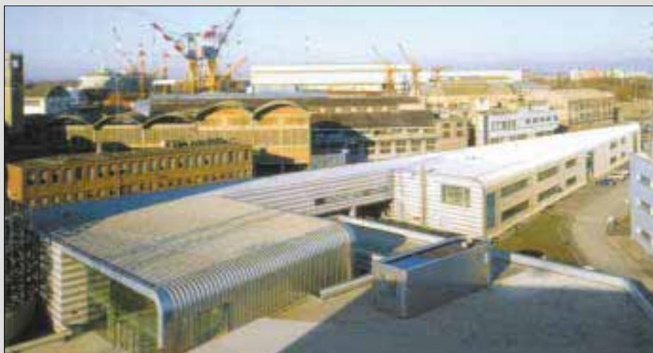
**Costruzioni del secondo lotto di ristrutturazione, con il grande edificio a forma di cuneo, dove tetti e pareti sono interamente rivestiti con lastre di acciaio inox EN 1.4401 (AISI 316), unite con aggraffatura meccanica.**
