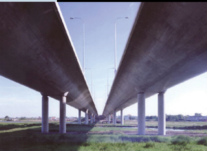
FIG|06 Per il ponte irlandese costruito sull'estuario del fiume Broadmeadow si è impiegato rebar inox austenitico al Molibdeno (EN 1.4436). L'incidenza sul costo totale dell'opera è stato solo del 3 %, a fronte di una richiesta di durabilità di almeno 120 anni.
