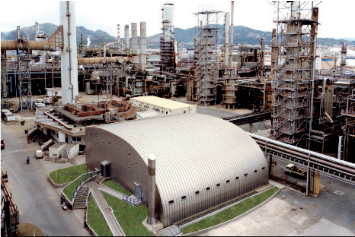
FIG 02 L'involucro della sala controllo delle Raffinerie Sarde Saras. L'atmosfera è resa ancor più aggressiva dalle emissioni della raffineria stessa.
