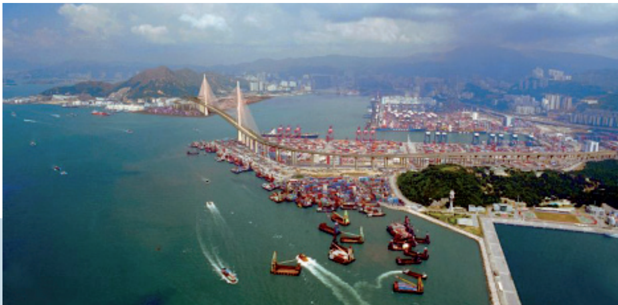
FIG|05 Per il rivestimento dei due piloni di sostegno dello Stonecutters Bridge a Hong Kong verrà impiegato acciaio inossidabile duplex del tipo EN 1.4462.
