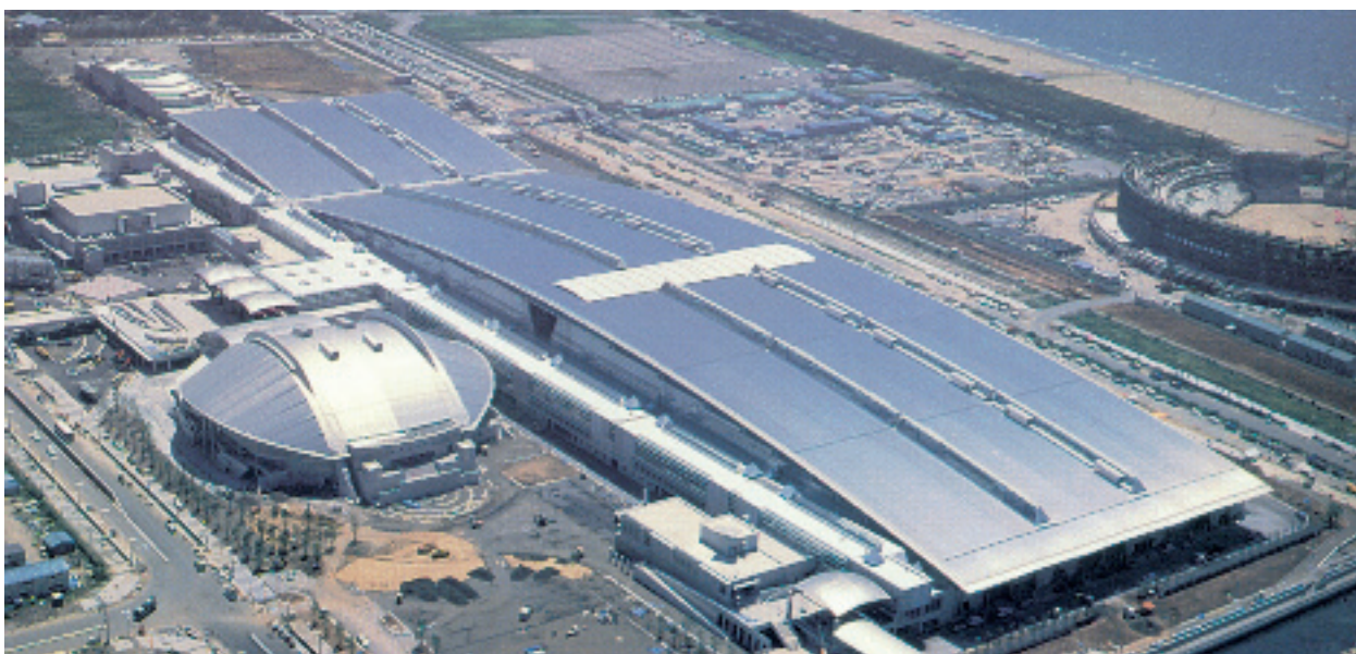
FIG|04 Per la copertura del Japan Convention Center, in riva al mare, è stato impiegato acciaio inossidabile ferritico contenente molibdeno (da "Successful use of stainless steel building materials" n.12013, edita da Nickel Institute, www.nickelinstitute.org ).
