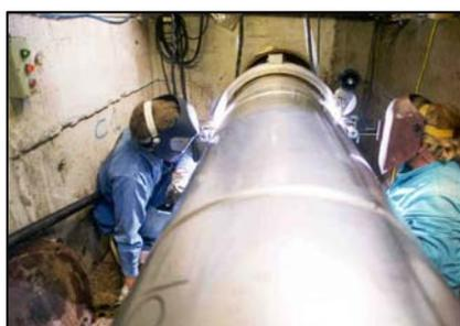
In pratica si è eseguito un intubamento della condotta in ghisa con una nuova in AISI 304, del diametro di 550 mm e spessore 2,5 mm in spezzoni da 1550 mm, saldati di testa (in automatico) tra loro e spinti all'interno della tubazione preesistente.
