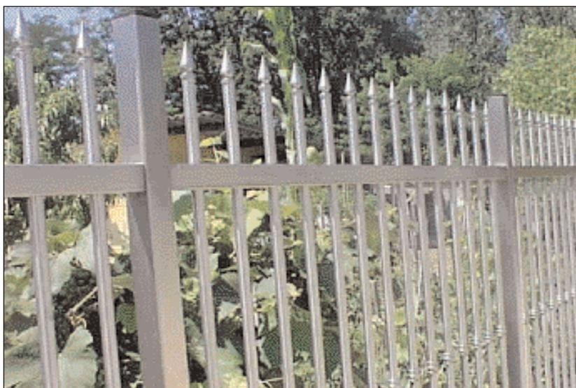
Fig. 16 Cancellata in acciaio inox realizzata utilizzando tubo tondo e rettangolare.
