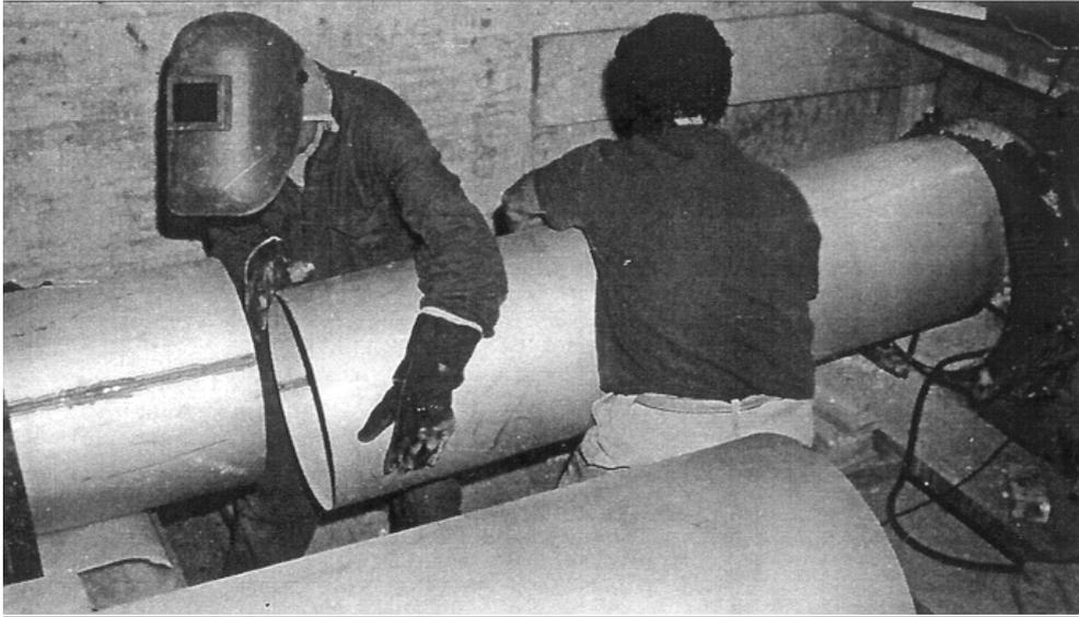
**Figura 6: momenti dell'intubamento delle vecchie condotte dell'acquedotto di Torino.**
