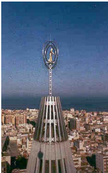
La sommità della chiesa della Madonna delle Lacrime (SR) ed il dettaglio degli elementi strutturali in acciaio inossidabile.
