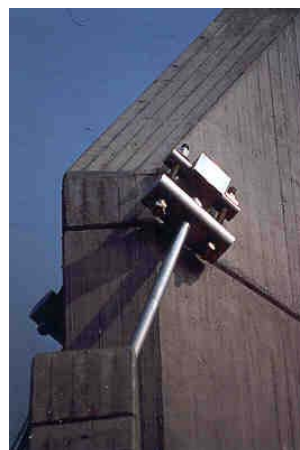
Tiranti di acciaio inox nella chiesa di Vimodrone (MI) e dettaglio dei punti di ancoraggio.
