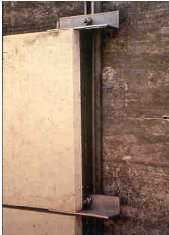
Ancoraggi e profili di sostegno di un tamponamento "a cappotto" eseguito con lastre di marmo.
