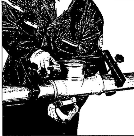
**Fig. 21** Si apre la ganascia estraendo la spina di chiusura, poi si avvolge la ganascia attorno alla camera toroidale del raccordo. La scanalatura della ganascia deve abbracciare la camera dell'O-Ring. La guancia di destra della ganascia deve sempre essere rivolta dalla parte del tubo, altrimenti non è possibile chiudere la ganascia.
