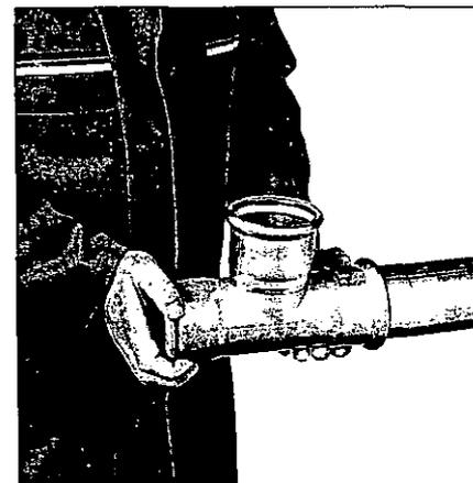
Fig. 19 Imboccare il tubo nel raccordo con leggera rotazione e contemporanea pressione in senso assiale fino all'arresto. La marcatura fatta precedentemente con l'apposito attrezzo permette di verificare la corretta penetrazione del tubo. Se il tubo non entra fino all'arresto, la pressatura non riuscirà a dare al giunto la resistenza che deve avere.
