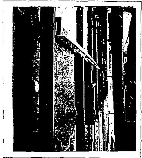
posizionamento in facciata di lastre in marmo, grigliate per la parte infissi e piene per quella cieca. Anche qui si è prima stesa una rete di profili annegati nelle solette, a cui poi sono stati fissati gli ancoraggi, in AISI 304, per le lastre. (fig 8)
