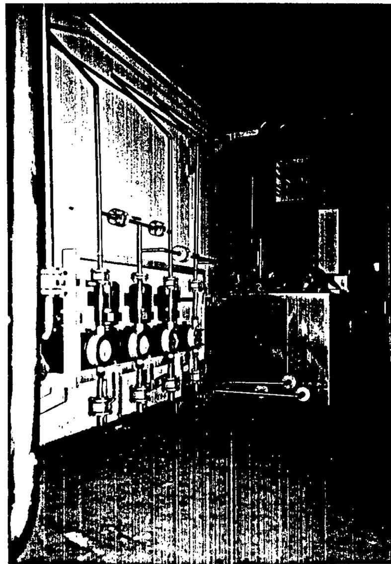
Sistema automatico di preparazione e dosaggio del polielettrolita per il trattamento chimico-fisico e la disidratazione del fango chimico in un impianto di trattamento delle acque di falda.
