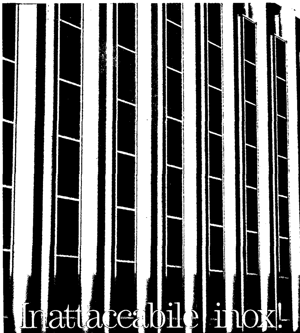
Facciata del CSM (Centro Sviluppo Materiali) di Castelromano (Roma), realizzata con elementi inox.
