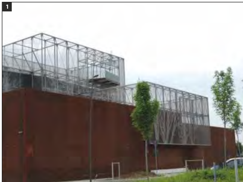
Figg. 1 e 2 Edificio adibito alla camera anecoica caratterizzato da pannelli di tela meccanica di acciaio inossidabile.
