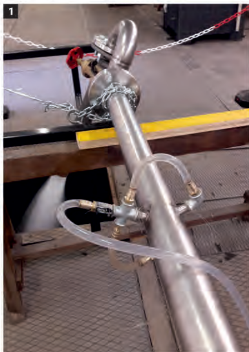
Fig. 6 Vista del terminale a "collo d'oca" dell'impianto con valvola di regolazione.
