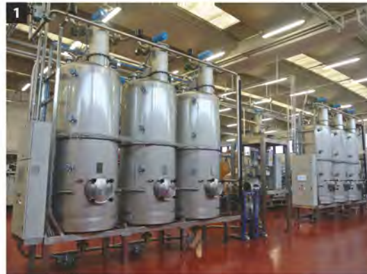
Fig. 1 L'impianto di stoccaggio e degasaggio del caffè macinato, realizzato in acciaio inox EN 1.4301 (AISI 304).
