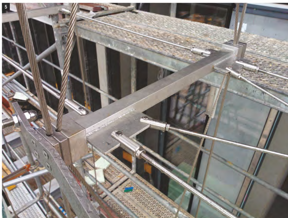
Fig. 2 • L'area del progetto non presenta un'atmosfera particolarmente aggressiva, quindi si è scelto di utilizzare acciaio inox AISI 303 per tutti i componenti della facciata. Anche tutta la tiranteria per la struttura reticolare, fatta eccezione per le funi per le quali è stato utilizzato l'AISI 304, è stata realizzata in acciaio inox AISI 303.
