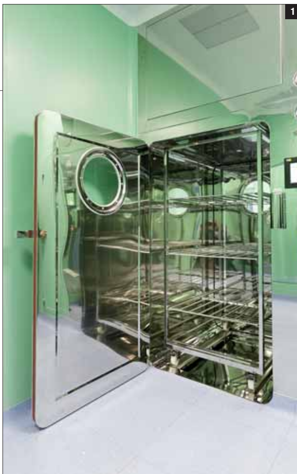
Fig. 1 – I pass box progettati e realizzati dall'azienda oggetto dell'articolo sono dotati di una camera interna a doppia porta, all'interno della quale si effettuano cicli di bio-decontaminazione. Si introducono innanzitutto i materiali dal lato non sterile, quindi si satura la camera con VPHP e, infine, si area forzatamente per consentire l'apertura e lo scarico in sicurezza dei materiali nel locale sterile.
