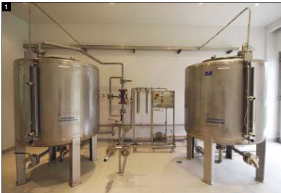
Fig. 1 – I reattori di argentizzazione e miscelazione. Tubi, lamiera, viteria e flange sono in acciaio inox AISI 304 e 316.
