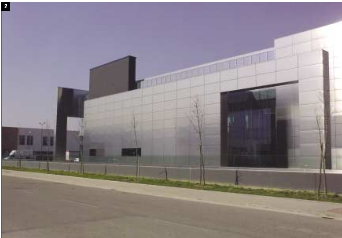
Fig. 2 – Ultimazione dei lavori della stessa facciata con rivestimento in acciaio inox 470LI.
