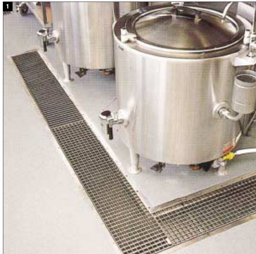
Fig. 1 – Grigliati in acciaio inossidabile AISI 304 elettrolucidati installati presso una cantina sociale (settore enologico), impiegati nella copertura di canali di drenaggio delle acque di lavaggio utilizzate per la pulizia della cantina.
