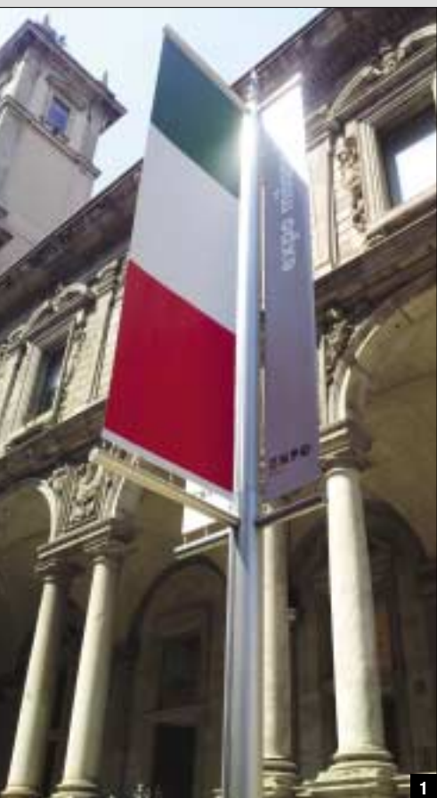
Fig. 3 – Il tubolare inox verticale superiore misura 139,7x4 mm e il tubolare inox verticale inferiore misura 168,3x4 mm.
