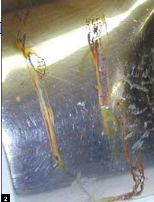
Fig. 2 – Dettagli di un particolare microfuso in AISI 316. Le porosità superficiali hanno generato fenomeni di ossidazione dopo poche ore di esposizione alla nebbia salina, evidenziando così una lacuna nel processo produttivo.
