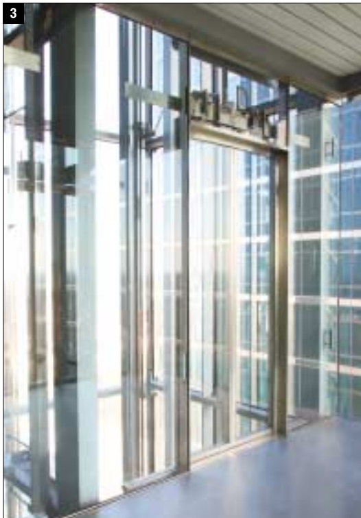
Fig. 3 – Vista delle porte di piano dall'interno del vano ascensore.
