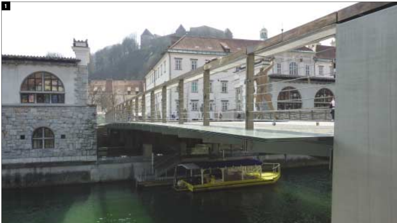
Fig. 3 – Il basamento della passerella è stato realizzato in vetro.
