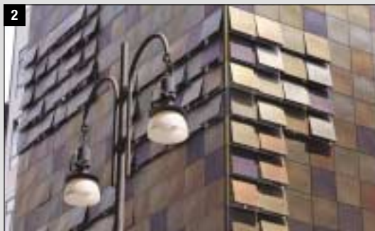
Fig. 1 – Il materiale utilizzato per produrre il rivestimento di facciata doveva essere tale da permettere la realizzazione di pannelli rigidi, consentire la microforatura con passo e profondità corrette per le prestazioni ottiche richieste, dare una resa cromatica non uniforme e molto simile a quelle del bronzo, dell'ottone, del rame e dell'oro.
