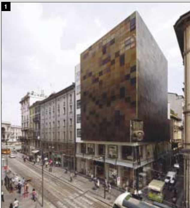
Fig. 1 – Il materiale utilizzato per produrre il rivestimento di facciata doveva essere tale da permettere la realizzazione di pannelli rigidi, consentire la microforatura con passo e profondità corrette per le prestazioni ottiche richieste, dare una resa cromatica non uniforme e molto simile a quelle del bronzo, dell'ottone, del rame e dell'oro.
