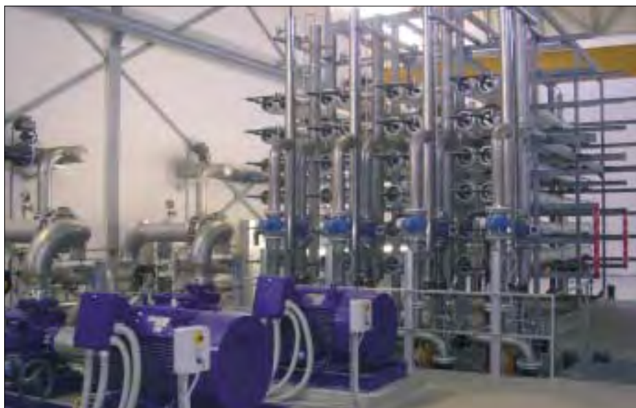
Pompe di adduzione del primo stadio di processo con tubature in acciai inox duplex che portano l'acqua alle membrane di filtrazione ad osmosi inversa.
