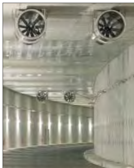
La galleria "Le Vigne" di Cesena, con 4 dei 14 ventilatori in acciaio inox.
