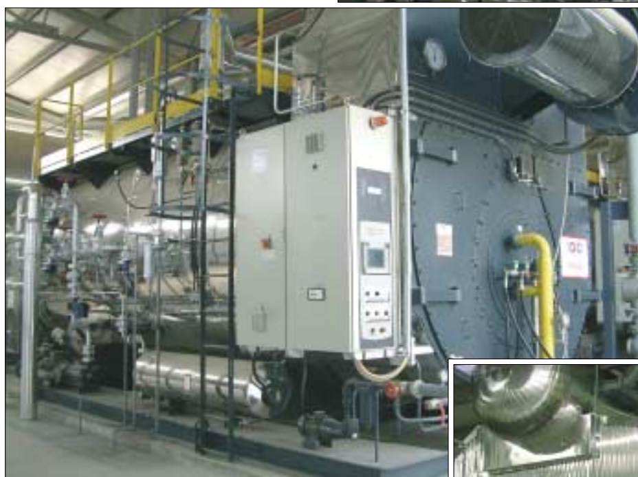
Generatore di vapore a tubi di fumo.
