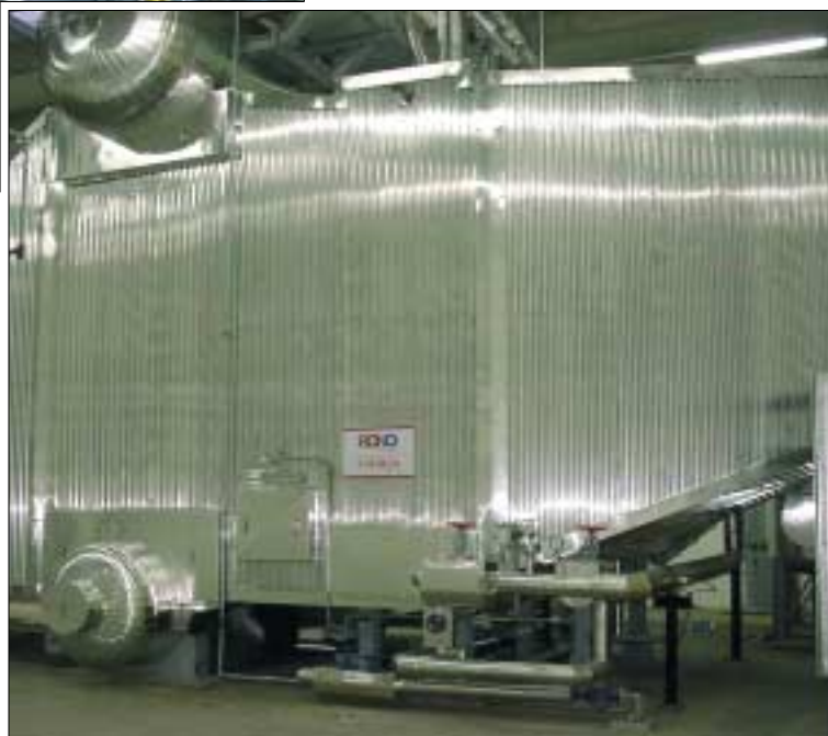
Generatore di vapore a recupero da turbogas.
