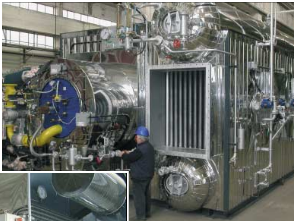
Generatore di vapore a tubi d'acqua.
