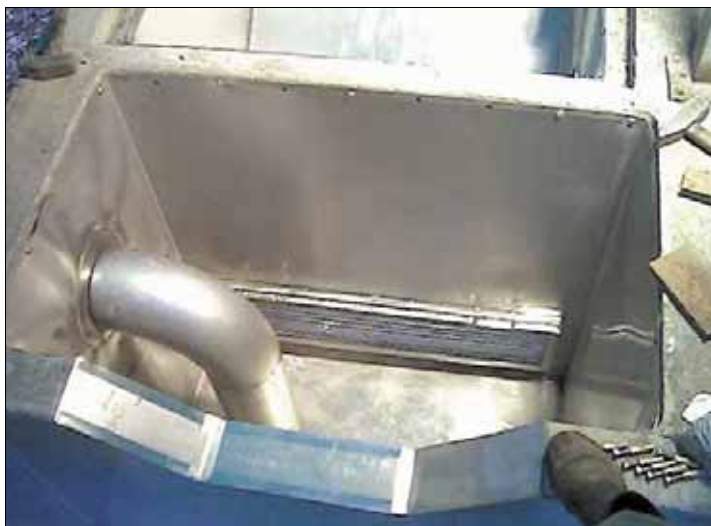
Il canale di adduzione dell'acqua dal torrente è rivestito con lamiera inox.
