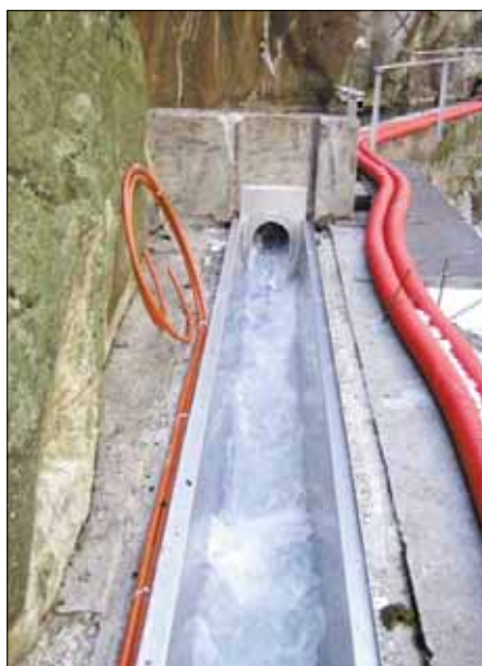
Il canale di adduzione dell'acqua dal torrente è rivestito con lamiera inox.
