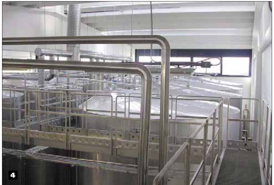
Fig. 3 e 4 - Cantina di prima fermentazione spumanti costituita da 15 serbatoi, da 600 hl, in acciaio inox EN 1.4301 (AISI 304), con ultima virola e tetto in EN 1.4401 (AISI 316). Anche la scala a rampe, autoportante, e le passerelle di collegamento sono realizzate completamente in acciaio inox EN 1.4301 (AISI 304).
