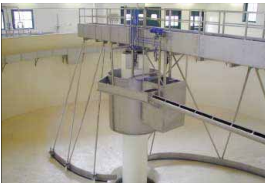
Vallarsa: ponte circolare a trazione periferica. La passerella di ispezione con i relativi parapetti e la lama raschiante sono interamente realizzati in acciaio inossidabile.
