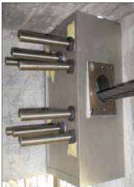
Il deviatore centrale che consente di trasformare la tensione dei cavi (racchiusi entro guaine inox dello spessore di 2 mm) in una spinta verticale.
