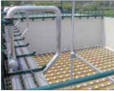
Lavis: vasca di aerazione a bolle medie. Il sistema di distribuzione dell'aria è realizzato in acciaio inossidabile EN 1.4301 (AISI 304).
