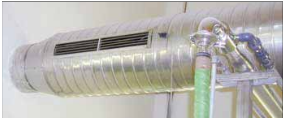
Vallarsa: particolare dell'impianto di deodorizzazione. Il convogliamento dell'aria verso i filtri a carboni attivi avviene a mezzo di condotte in acciaio inossidabile.
