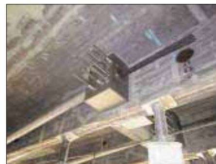
Sopra e a sinistra: particolari dei "nasi" di ancoraggio realizzati in acciaio inossidabile e fissati contro l'anima delle travi in cemento armato a mezzo di barre inox filettate, serrate con martinetti idraulici.
