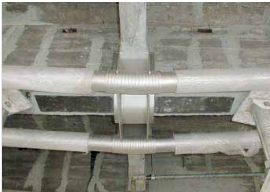
Il deviatore centrale che consente di trasformare la tensione dei cavi (racchiusi entro guaine inox dello spessore di 2 mm) in una spinta verticale.
